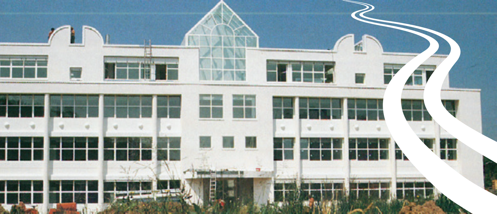
Bild 3: Der Neubau in Muri, im Mai 1989
